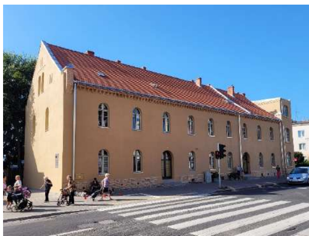
Fot. 5. Budynek dawnego arsenału
