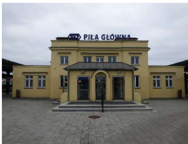
Fot. 18. Zespół stacji kolejowej Piła Główna
