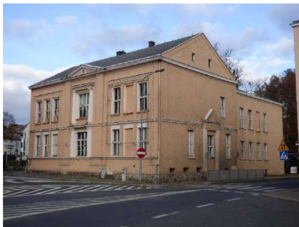
Fot. 8. Budynek dawnej loży masońskiej Borussia
